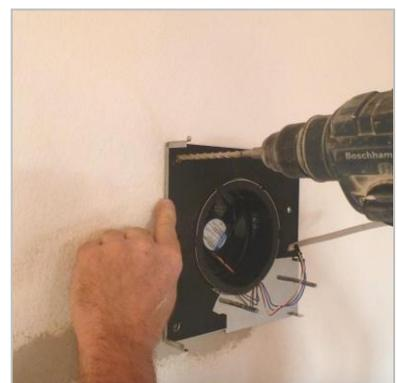
7. Falls Ihre Wand weniger als 12 cm dick ist, montieren Sie die Gerätehälften mit den beigeefügten Abstandshaltern.
