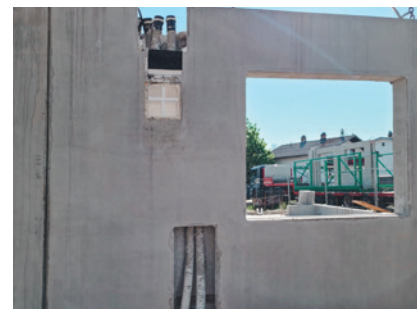
Setzen der Fertigwand inklusive aller Leitungen
